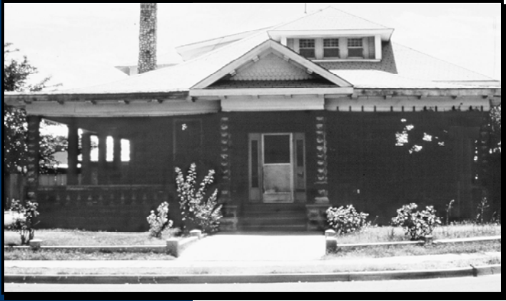
Antes del Terremoto
