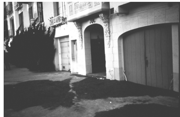
Figura 40 - Terremoto de Loma Prieta, Octubre 17, 1989. La expansión lateral, las arenas movedizas en suspension causaron daños en el Distrito de Marina de San Francisco, a 60 millas de distancia del epicentro.
