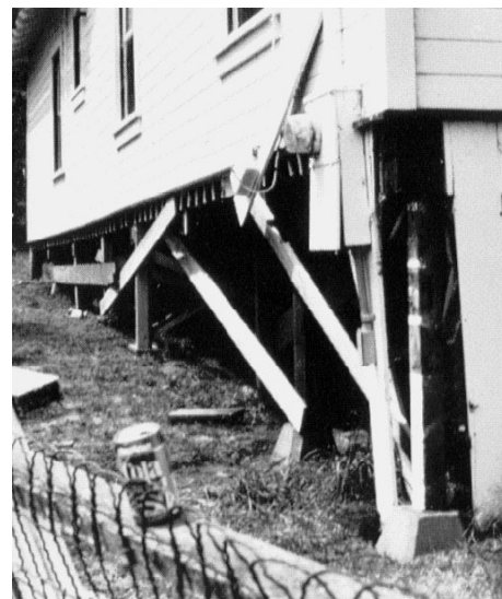
Figura 18 – La base o poste de cimiento debajo de esta casa se deslizó debido a un terremoto reciente.
