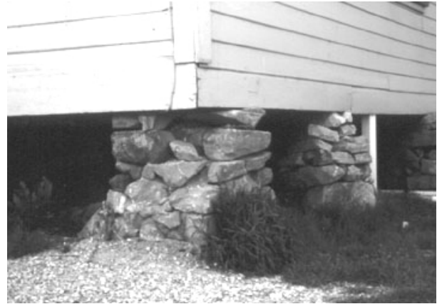
Figura 19 – Éste es un cimiento de piedra sin refuerzo. Usualmente fallan durante terremotos.
