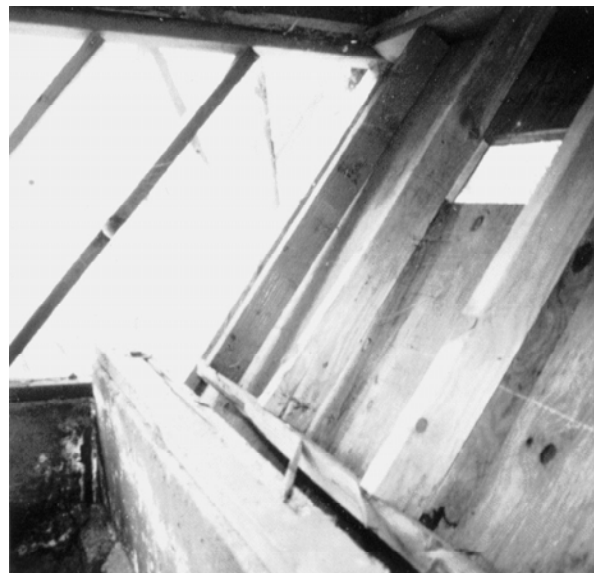
Figura 23 – Esta fotografía nos muestra el detalle interior de una casa similar a la foto de arriba, mostrando que un edificio con una pared sin refuerzo puede causar daños considerables.
