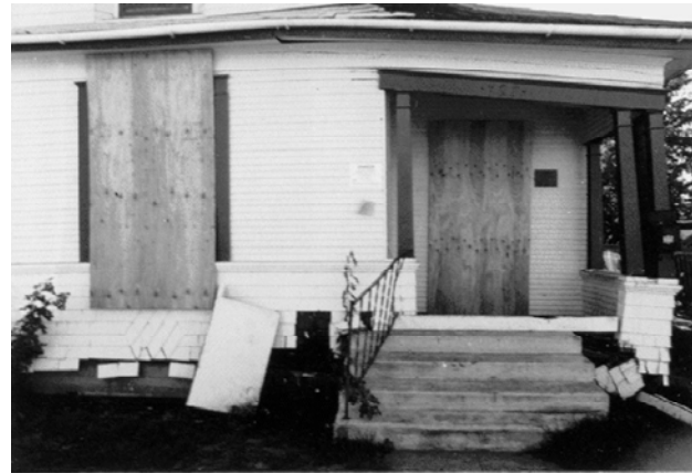
Figura 13 – Esta casa no estaba anclada y se deslizó fuera de sus cimientos. Algunas veces el daño pueden ser tan graves que las casas tienen que ser demolidas.
