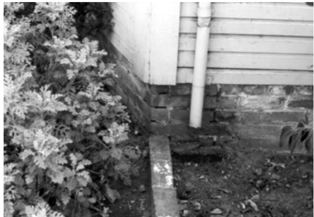
Figure 20 – Se observa que los ladrillos están expuestos en esta mampostería de cimiento sin refuerzo.
