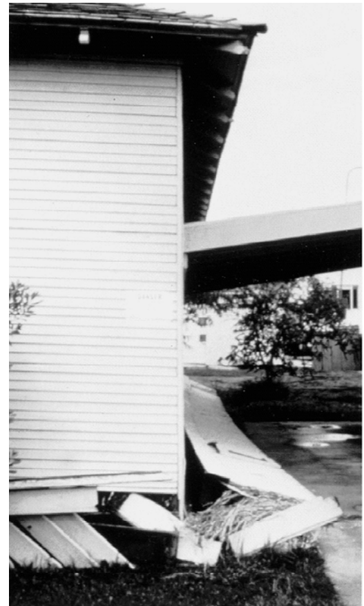
Figura 15 – Daños a la casa debido a fallas del muro bajo.
