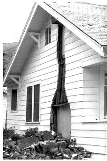
Figura 4 – Terremoto de Northridge, Ene. 17, 1994 Derrumbe de la chimenea – daño común en mampostería sin refuerzo.
