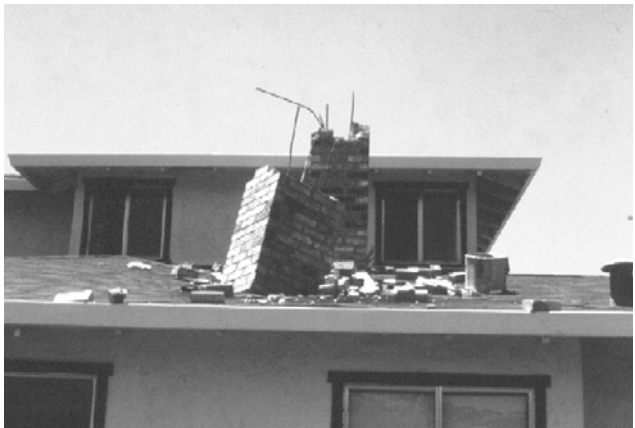
Figura 34 – Terremoto Morgan Hill. Parte de la chimenea cayó sobre el techo.
